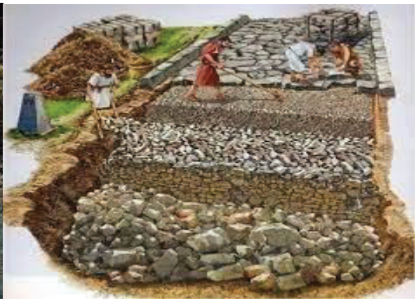
Izgradnja rimskog puta
